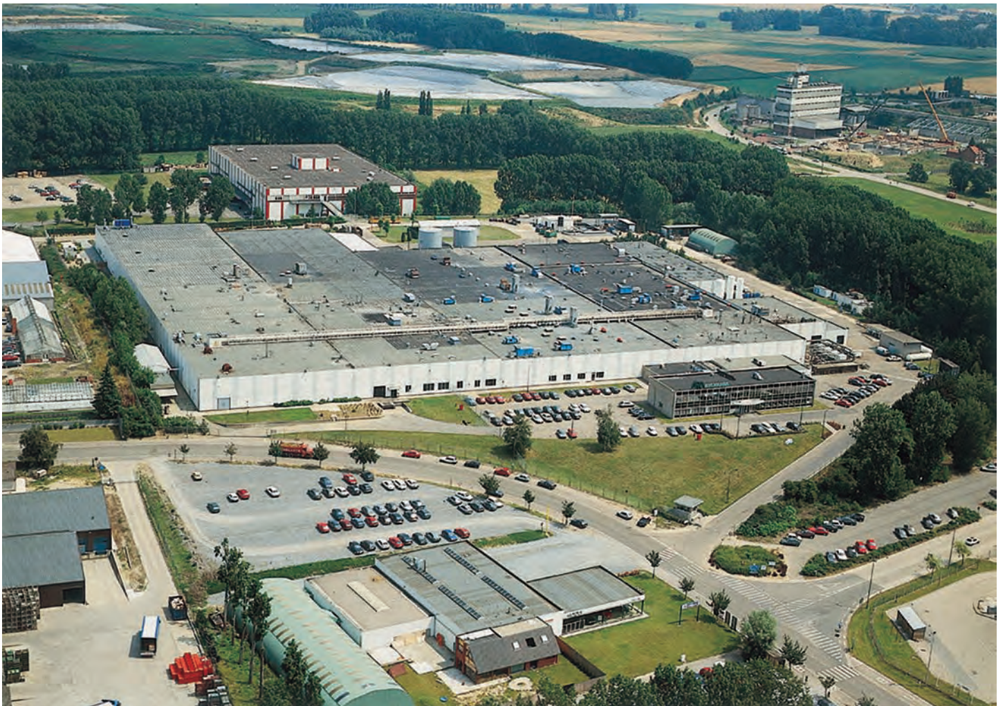
Tienen Factory, Belgium
